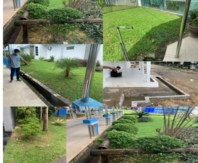
Gambar 4. Peninjauan lokasi pemasangan TCT
